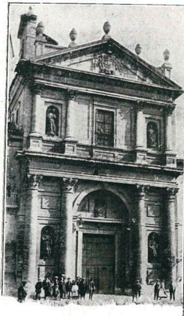
Las Angustias (fachada)
